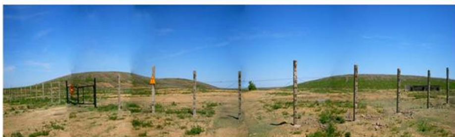
Рис. 4. Ограждение на бывшей шахте № 8 в поселке Заозерный (Степногорск)
