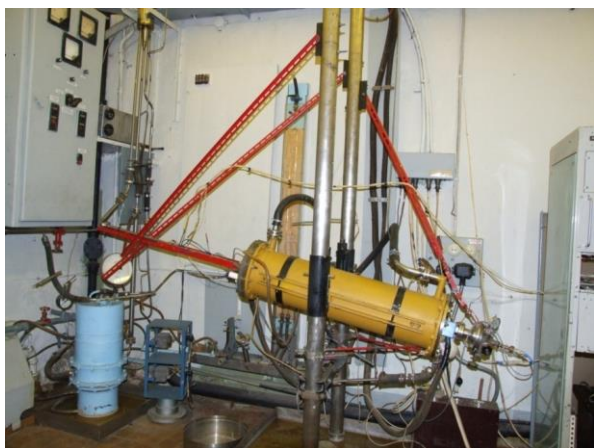
PK-1. УНУ «Ртутный стенд» МЭИ
