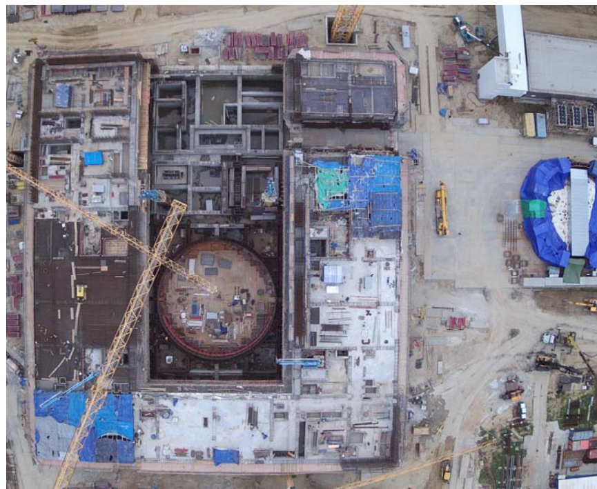
Площадка, август 2023. Здание реактора
