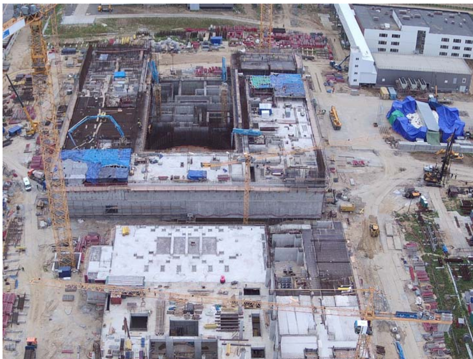
Площадка, август 2023. Вид на здание реактора и машзал
